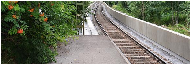
Figur 1. Spårnära skärm monterad för att reducera buller.
